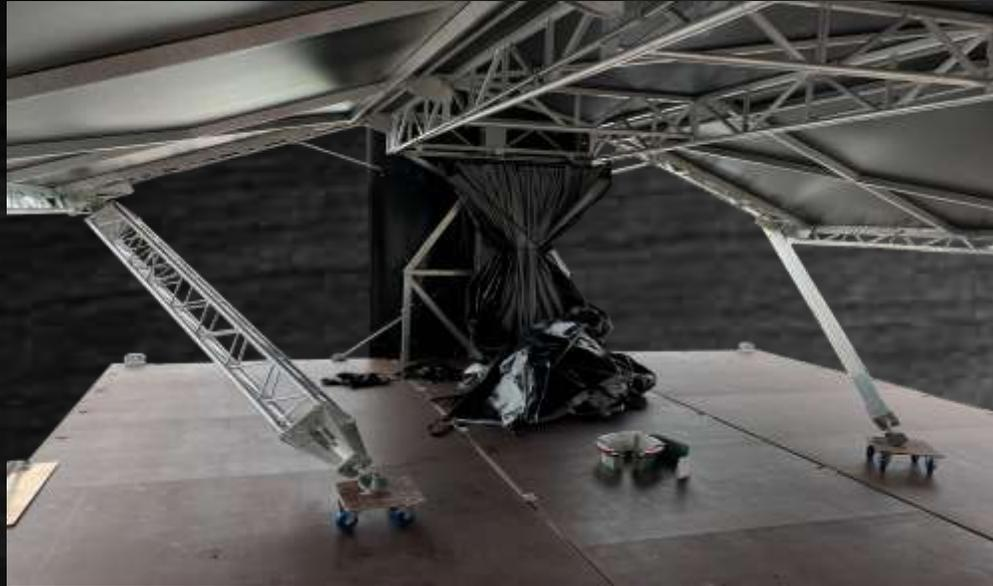
Toutes les différentes étapes du montage se font à hauteur d'homme, il n'est plus nécessaire d'escalader pour sécuriser la toiture ou mettre en place le fond de scène.
